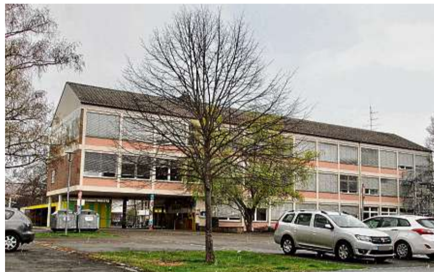
Wenn die alten Schulgebäude einmal abgerissen sind, ergeben sich ganz neue Möglichkeiten für das Quartier 2020. Die Caritas Singen Hegau ist die erste soziale Einrichtung, die sich hier mit neuen Wohnformen für Menschen mit Behinderungen einbringen möchte.
